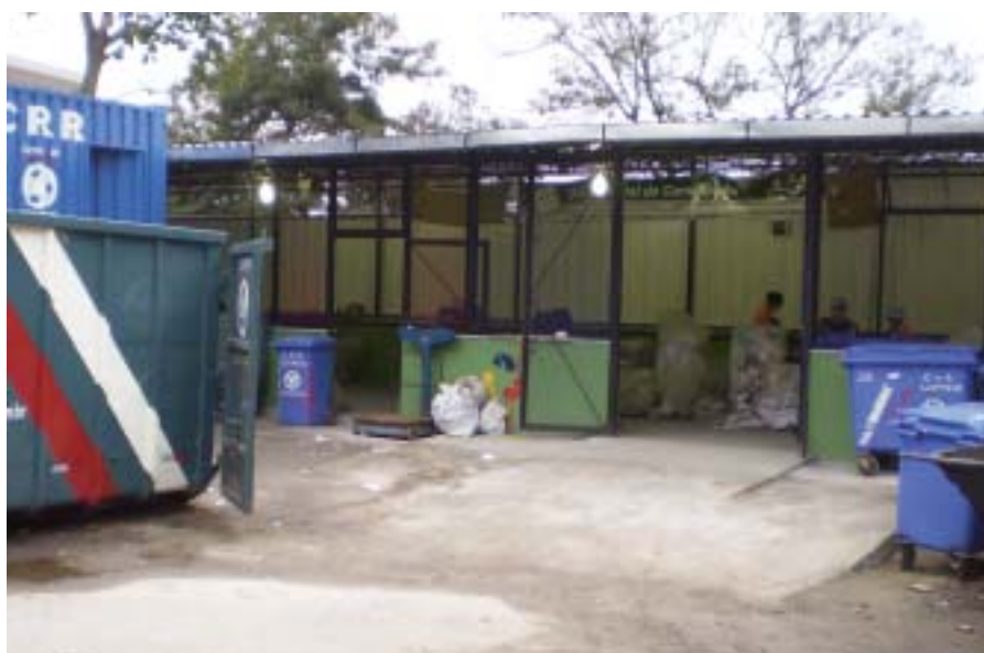
Galpão direcionado a reciclagem
